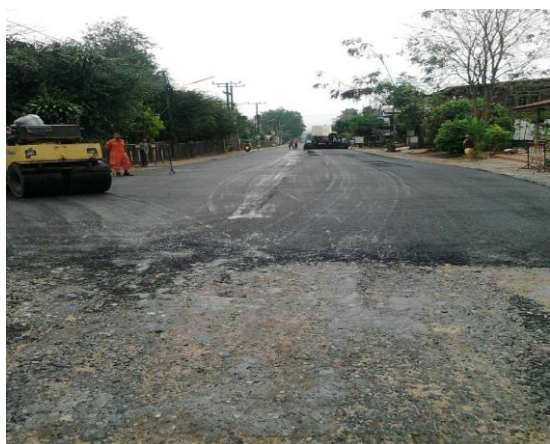
ปรับปรุงผิวจราจร ถนนคอนกรีต ถนนเทศบาล๑ จากทางหลวง ๒๐๒๓ ถึงถนนศรีธาตุ ๑ ด้วยแอสฟัลติก
