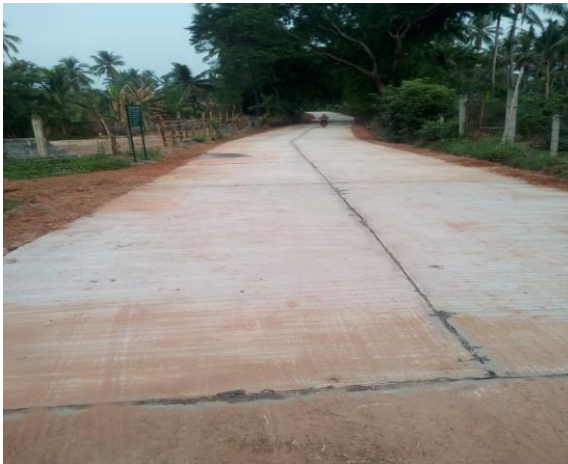
โครงการก่อสร้างถนน คสล.ถนนศรีเจริญจากถนนเทศบาล ๑๑
